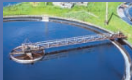
Wasser- und Abwassertechnik
